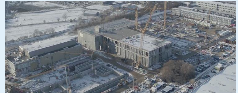
Konstruktion af ny fabrik i Kalundborg
